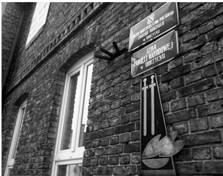
Fragment elewacji szkoły w Obrzycku (Źródło; Internet)
